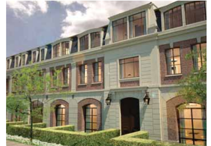
Rue de Grenelle 7th Arrondissement, Paris
